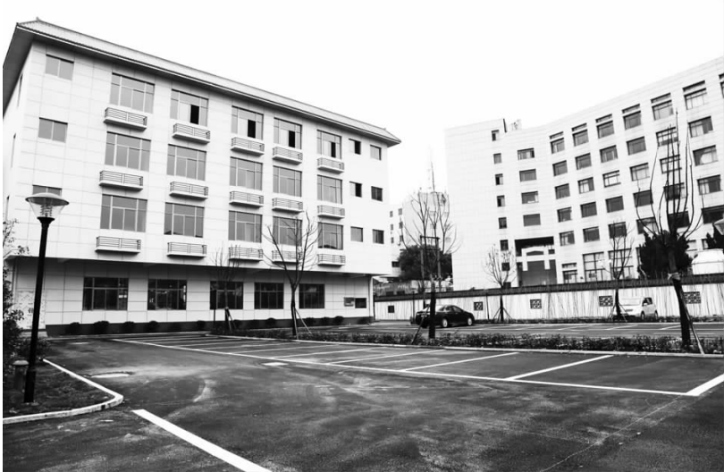
东门广场公共停车场(农业银行南侧)经过几个月施工,目前已进入配套设施完善阶段,预计近期将对外开放。图为已建成的停车场一角。 林山 摄
