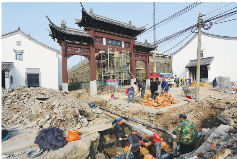
去年下半年,孟城驿二期工程开工以来,施工进度顺利。为确保该工程“4·18”前顺利完工,正月初六,施工人员即返场开始紧张施工。
