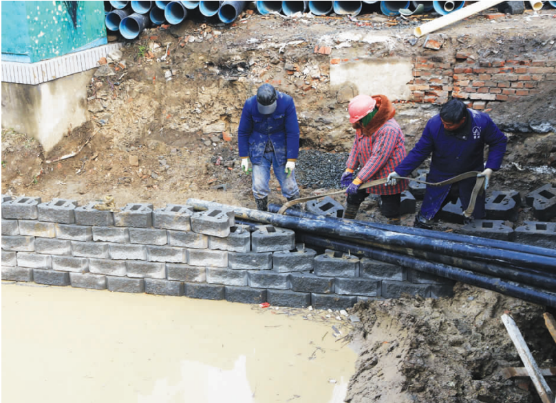
近年来，我市着力建设生态高邮，不仅注重环境整治，而且在工程建设中注重采用生态材料，以更好地保护环境。图为施工人员正在东门大沟采用生态材料施工的场景。 王林山 摄 今日总值班 胡行球 责任编辑 张维峰
