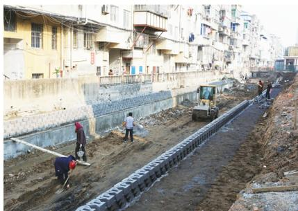
东门大沟下段整治工程是省南水北调输水干线水质达标工程之一,全长1300米,主要将河道南岸拓宽至8米,同时实施管道截污、绿化、亮化等工程,预计2015年春节前全部完工。图为施工人员正在城区团庄桥段施工。 王林山 摄
