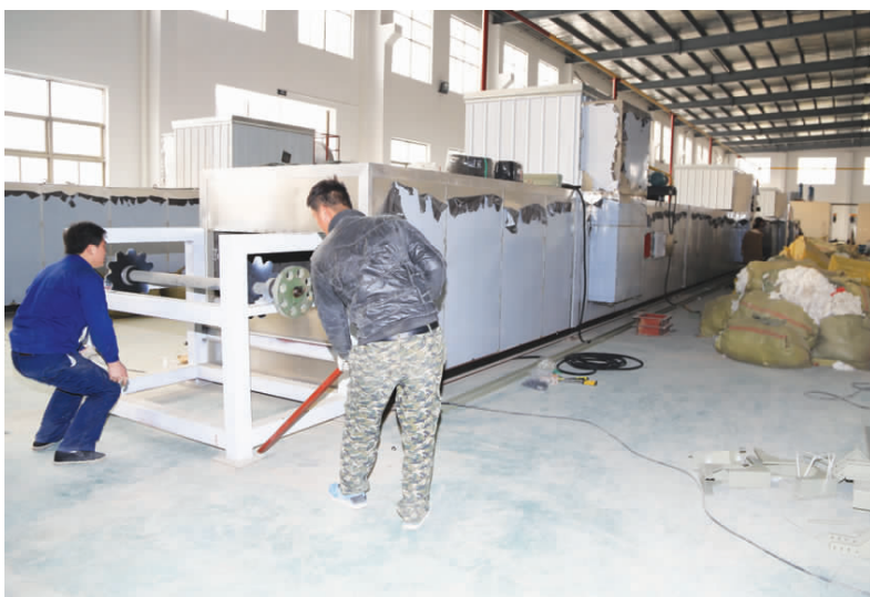
扬州佐仕科技有限公司今年 2 月落户位于开发区的电池工业园,计划总投资 10 亿元,目前主体厂房基本建成,部分设备正在安装调试中,明年初将试运行。图为施工人员在安装设备。
