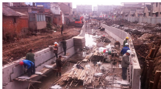
市河二期整治工程于今年9月施工,目前已完成河道开挖、岸墙、底板浇筑等主体工程80%以上工程量,预计工程于今年年底完工。图为施工人員正抓紧施工。
