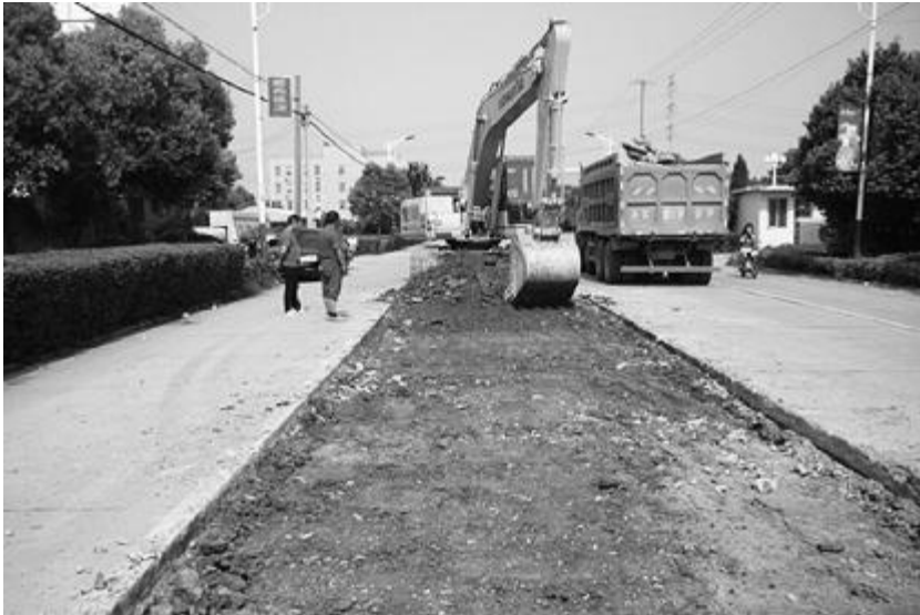
正值秋收秋种时节,界首镇主干道——孟陵北路路面突然拱起。近日,该镇组织抢修突击队,对损坏严重的段面进行机械开挖,用水泥混凝土复浇,并对多处路面坑塘用沥青修补。图为修补现场。
