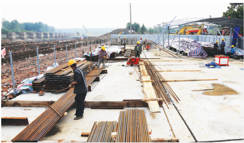
当前运东船闸扩容工程进展顺利，上下游围堰已合龙，旧船闸已拆除过半，目前施工人员正在抓紧拆除旧船闸剩余部分，为新船闸建设做准备。图为施工人员正在工地上施工。王林山 摄
