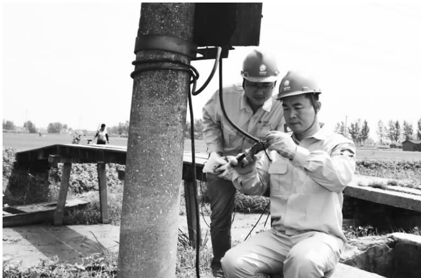
日前,汤庄镇京汉村8组自筹电力线路的打水口突发用电故障,村民除草药物已施入田中,急需注水。接到报修电话后,汤庄供电所职工迅速赶到现场进行处理,及时恢复了供电。图为供电职工正在处理因氧化导致接触不良的电线。 林华鹏 朱军 摄影报道
