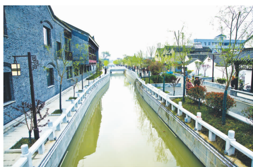
新建的南水关段居民新区
