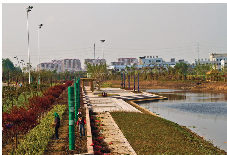
北关河改造工程目前已进入最后冲刺阶段, “4·17”前将全面完工。图为施工人员进行工程扫尾工作。 王林山 摄
