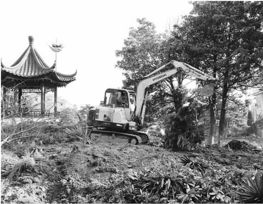
高邮运东船闸扩容工程在即,为保护闸区内生长多年的广玉兰、雪松、龙柏、香樟等树木,连日来,船闸工作人员对在扩容工程开挖线以内的树木进行有序移植,对开挖线以外的树木进行挂牌编号保护。图为树木移植现场。 王龙 任仁 摄
