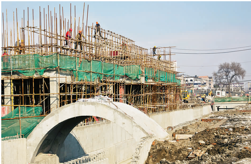
穿心河沿线整治工程是我市 2013 年“双十”工程之一,目前首期工程河道整治工作已结束,正进行配套设施建设。图为施工场景。
