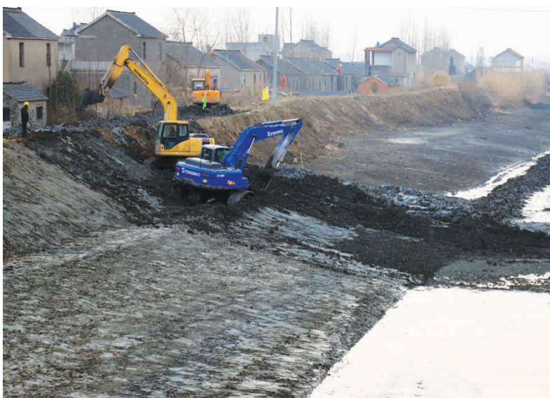
横泾河整治工程于去年 11 月底启动,对 7.75 公里长的河道进行疏浚。整个工程将于今年汛期前完工。图为施工现场。
