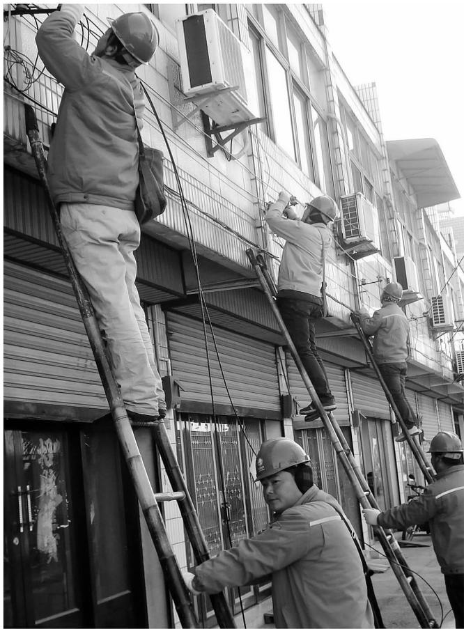
春节临近,供电公司组织精干力量,对市区及集镇、乡村一些负荷较重的低压接户线进行整改,以保障城乡居民春节期间可靠用电。图为日前龙虬供电所职工在龙虬集镇兴隆街整改居民低压接户线。
