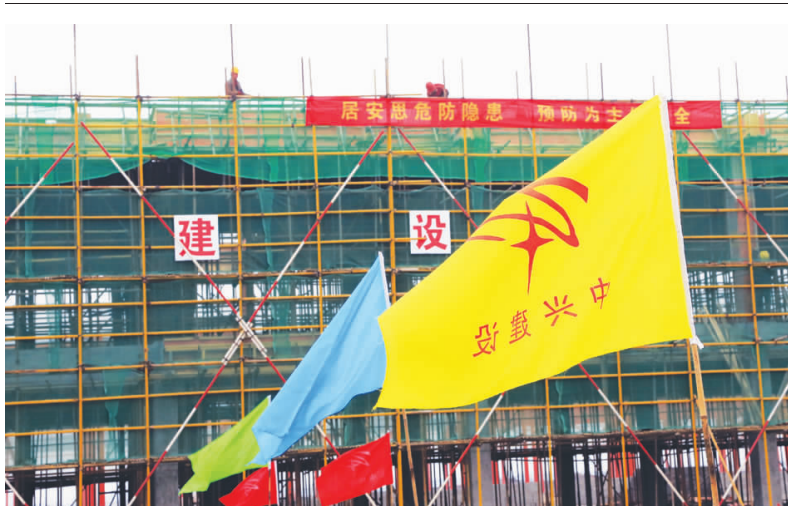
去年8月,计划总投资1亿美元的美国艾诺斯集团江苏华达电源系统有限公司落户开发区电池工业园。该公司建成后,主要从事各类工业用电源电池的研发、生产和销售。目前项目主厂房正在建设中。图为施工人员正在施工的场景。 王林山 摄
