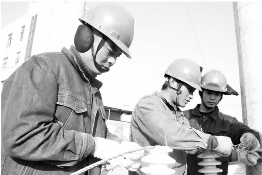
入冬以来,市供电公司组织外协单位施工人员进行“理论+实践”的技能训练,重点从施工安全、质量、工艺等方面,对拉线制作、绝缘子安装、架线等项目进行培训,以提高施工人员的施工技能和掌握现场安全的本领,为来年建设一流配电网打好前量。 图为2013年12月29日,电力施工人员正在集训。 林华鹏/摄
