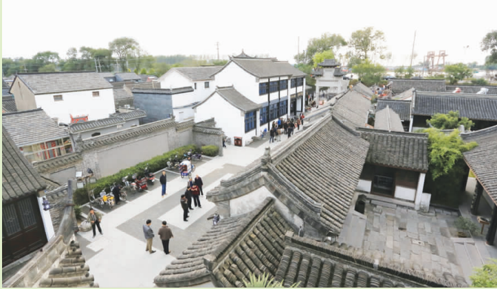
孟城驿扩容改造一期工程 孟城驿扩容改造一期工程含孟城驿扩容、城南历史街区修缮、南门大街整治三部分,整个工程秉承邮驿之风,传承邮驿文明,既保留了赵家宅、驿丞宅等具有历史风貌的旧居;又修建了独具特色的泰邮公馆和开放式花园;同时还设置历代名人咏颂高邮的诗词碑廊。扩容工程与孟城驿本体一脉相承,修缮的运粮巷、盐塘巷、詹家巷等历史街区与南门大街相互贯通。该工程于2013年4月18日开工,同年10月18日正式竣工时二期工程迅速启动。
