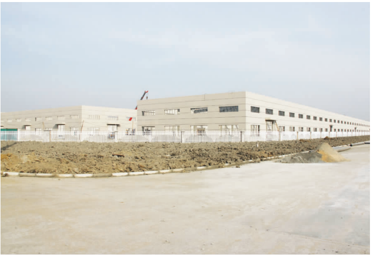
4、易事特光伏发电及智能电网系统项目,计划总投资10亿元。主要进行各类储能电池、光伏并网逆变器、智能电网系统等研发、生产,达产后可实现销售18亿元以上。
