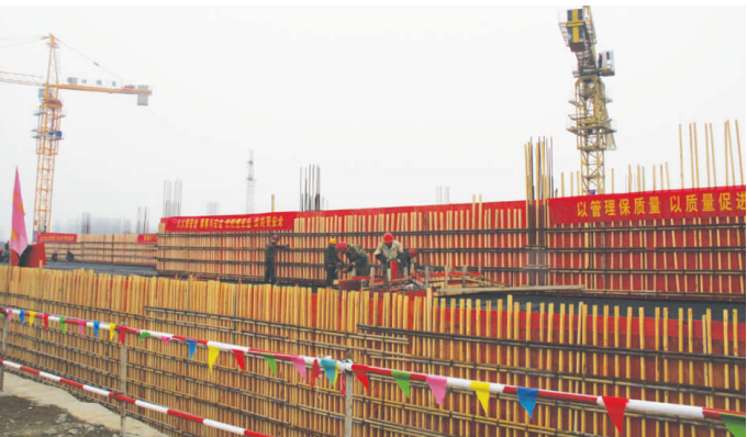
2、考斯特软件园项目,计划总投资1亿美元。建设集软件研发、市场总部、商务会议等功能为一体,以及科技型企业或科技研发机构、总部经济、现代服务业项目的孵化培育与创业创新基地。目前,一期5.6万平方米的智慧大厦主体工程已建至一层。
