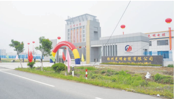
8、光明特种电缆项目,计划总投资10亿元。主要新建标准化厂房,新增各类高新技术生产、检测设备,进行军工舰船用、民用船舶用及风力发电用特种电缆的生产。目前,该项目已竣工投产。
