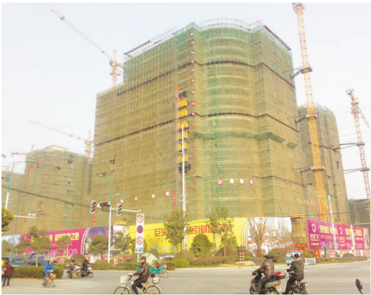
1、波司登世贸国际广场,总投资25亿元。包括五星级波司登国际大酒店、购物中心、大型超市等项目,是我市首个城市综合体项目。目前,部分项目主体已到10层以上。
