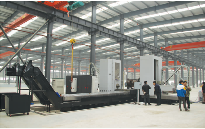
6、迅达重型工程机械项目,计划总投资10.3亿元。主要从事推土机、挖掘机等工程机械配套机械生产。目前,一期工程已建成投产,2013年开票销售已超过1000万元。
