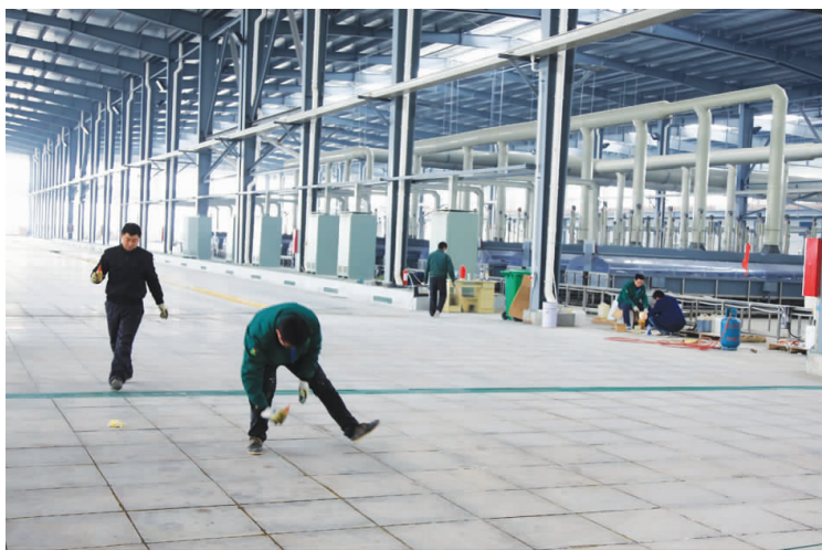
位于开发区的江苏海德森能源有限公司经过一年半的建设,目前主体厂房和附属厂房内部配套工程建设已经结束,正在安装设备,并加快进行科研楼内外配套设施施工,预计2014年春节后可试投产运行。图为施工人员在忙碌的场景。 王林山 摄
