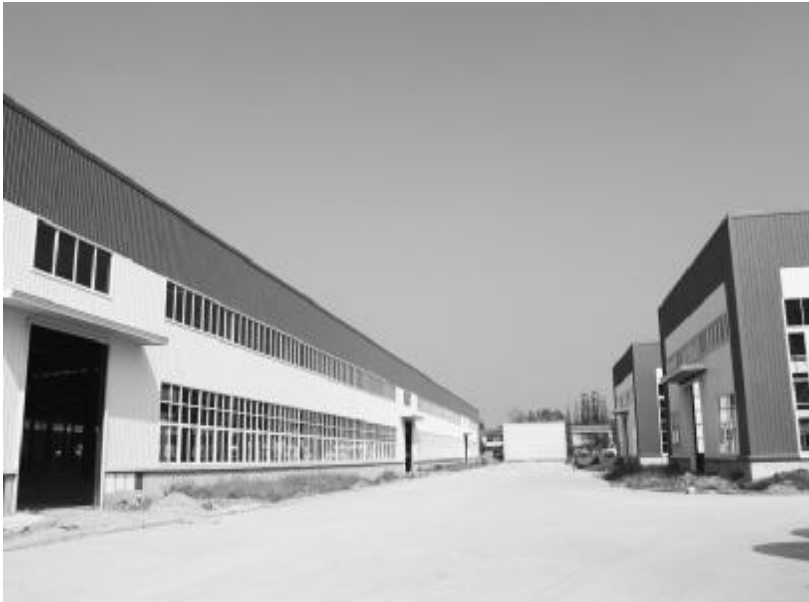
位于开发区内的中信戴卡汽车轮毂制造项目，计划总投资10亿元，目前已建厂房、办公用房及附属用房6万平方米。图为新厂房一角。 王林山 摄
