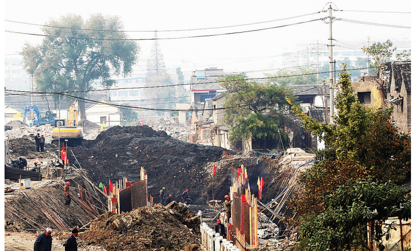
穿心河整治一期工程自开工以来进展顺利,目前城建部门正组织人员进行施工,预计明年 2 月底完工。图为施工人员在南水关附近施工的场景。 王林山 摄
