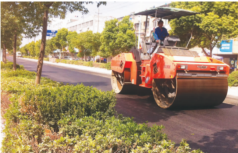
武安西路改造工程目前已进入路面沥青摊铺阶段,不日即将完工。图为压路机在碾压沥青路面。 周雷森 摄
