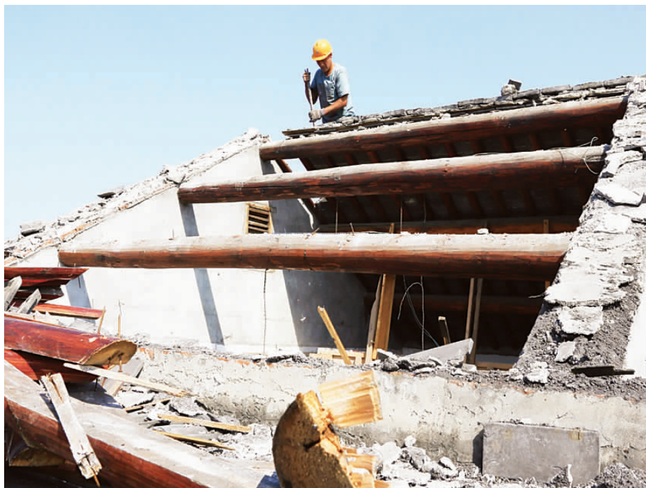
穿心河沿线整治工程房屋征收工作自本月 10 日开始以来,包干部门大力推进,广大被征收户积极支持,各项工作有序进行,目前房屋征收工作已接近尾声。图为 27 日施工人员在南水关附近拆除移交的房屋。
