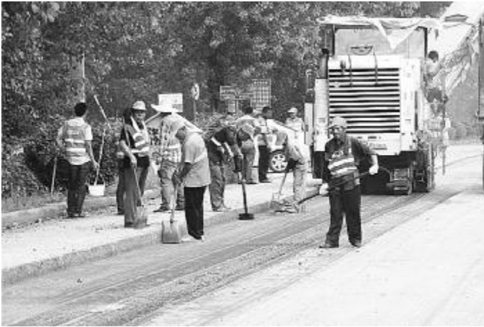
车樊路是连接我市车逻、八桥及江都樊川等乡镇的交通主干道。由于车樊路八桥段破损严重,从7月中旬开始,市交通局组织人员和机械对K0+000M、GCF K7+500M路段进行路面养护大修。图为23日上午,施工人员冒着高温抢修破损路面的场景。吴继原 摄
