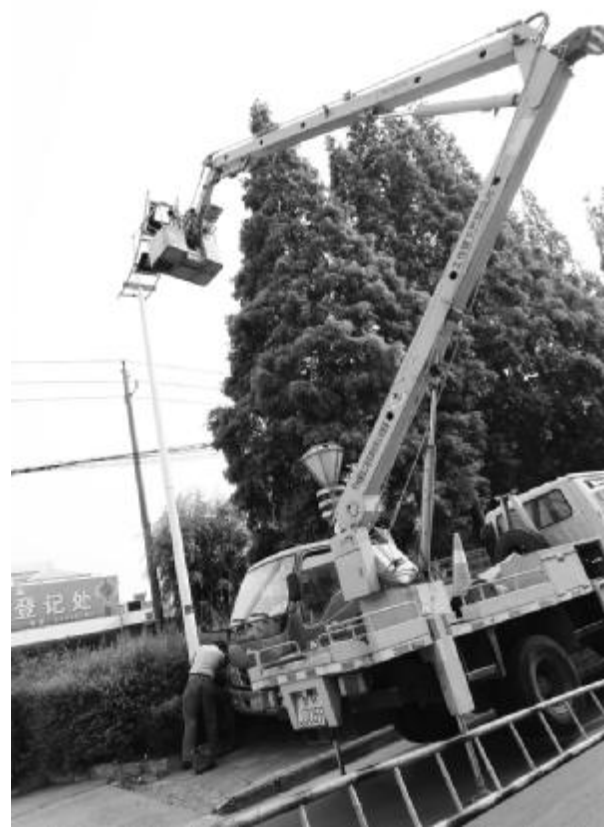
天气虽然炎热，但市供电公司路灯班的工作人员仍坚守岗位，及时抢修出故障的路灯，确保市民晚间出行方便。图为路灯班工作人员在南海路段检修路灯。王林山 摄
