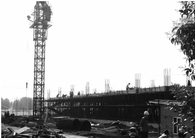
今年,横泾镇将卫生院迁建作为改善民生的重点惠民工程来抓,扎实推进项目建设。图为卫生院新址热火朝天的施工现场。姚红兰 周雷森 摄
