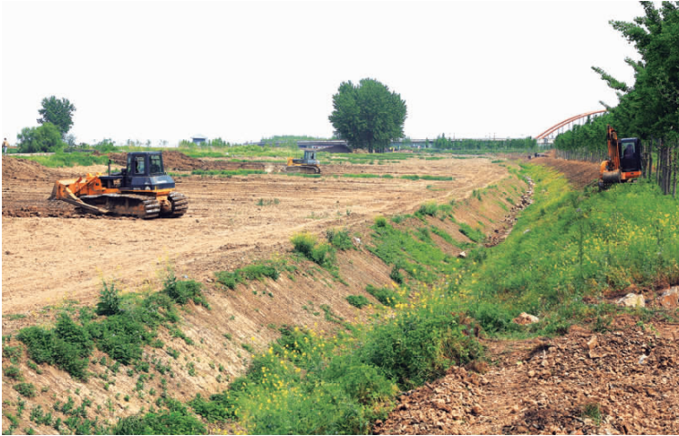
为让千年运河故道焕发青春，由国家运河申遗办公室牵头，投入千万元在我市南至镇国寺、北至御码头段运河故道实施改造工程。该工程今年 4 月动工，预计 6 月底完工。图为施工人员正在运河西堤段施工的场景。 王林山 摄
