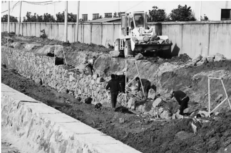
今年以来，高邮镇投入近千万元对镇工业集中区内的同心河实施驳岸改造工程和新建21路建设工程。预计工程将于6月底完工，届时将极大地改善高邮镇工业集中区内的环境及排水状况。图为施工人员正在施工的场景。
