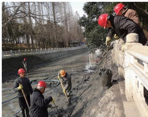
今年,市水利局继续实施城河畅通活水工程,主要对琵琶河、护城河上段、万斤河上段以及长生大沟上段进行清淤、清淤。图为3日下午,施工人员正在清理城河中的淤泥和杂物。
