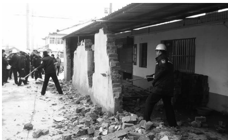
针对节后违章建筑增多的现象,市容管理执法大队城南新区中队加大查违、控违、拆违力度,实行新区、中队、村组联动,对违章搭建行为进行严肃查处,收到了处罚一起、教育一片的效果。图为违章建筑拆除现场。 赵文全 摄
