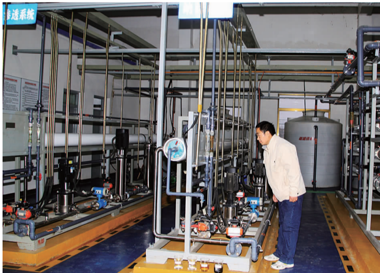
位于龙虬镇的朱家生活垃圾卫生处理场已通过国家一级无害化评估,目前每天处理垃圾300多吨,并同步过滤处理废气、污水等,尽最大努力保护好周边环境。图为工作人员正在察看渗透设备。 王林山 摄
