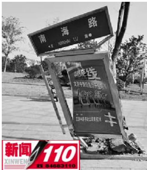
4日,位于南海路净土寺广场西出口处的指路牌被一辆车撞后,严重变形,存在安全隐患。现场一位保洁工告诉记者:“这块路牌已经不是第一次被撞了,这次被撞得比较严重。这里车来人往容易出危险,希望有关部门赶紧来瞧瞧。” 晓晖 摄
