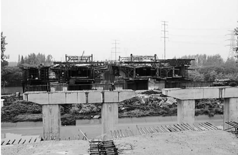
总投资1.3亿元的省道237高邮北澄子河大桥,主跨北澄子河三级航道,全长828.4米,宽61米,设计时速100km/h。目前,该桥桥梁下部构造已完成,正在进行主桥变截面连续箱梁和引桥梁板安装,预计2013年6月建成通车。图为记者日前在建设现场拍下的场景。 李久强 殷建荣 王道 摄
