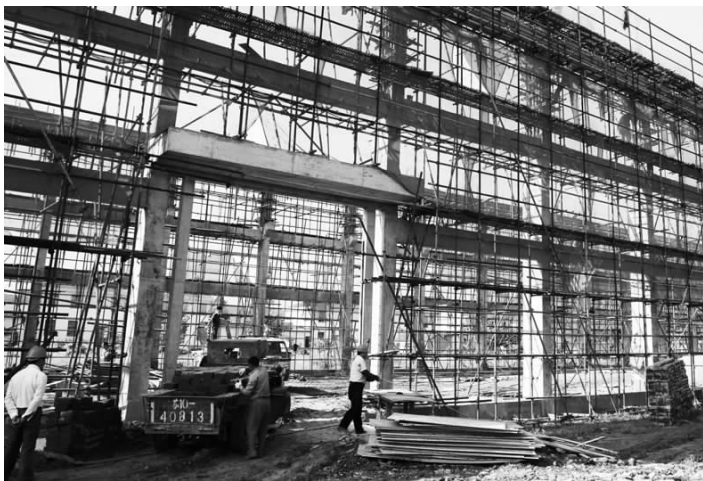
位于城南新区总投资 2980 万美元的江苏朗鸿机电项目，3.5 万平方米的标准化厂房正在建设，预计 11 月份设备将进场安装。图为施工人员在建设厂房的场景。郎建业 王林山 摄
