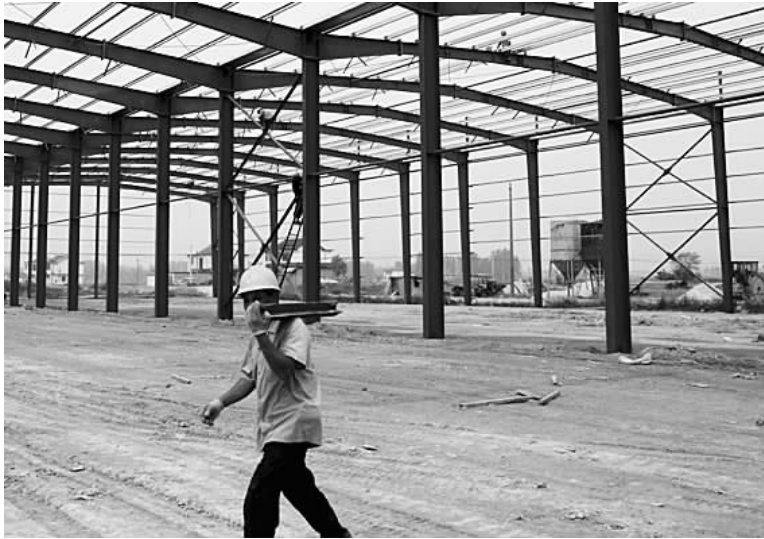
今年6月动工建设的爱力生蓄电池项目目前正在积极推进。该项目征地180亩,项目达产后,可年产蓄电池320万KVAH,实现年销售15亿元,创税1.5亿元。图为项目建设现场。
