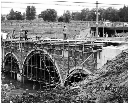
前不久,龙虬庄遗址荣获“江苏大遗址”称号。为进一步打造好这一历史文化旅游景点,有关部门和单位正按照遗址公园保护规划方案对遗址内基础设施进行全面改造。图为施工队正进行道路和景观桥梁建设。
