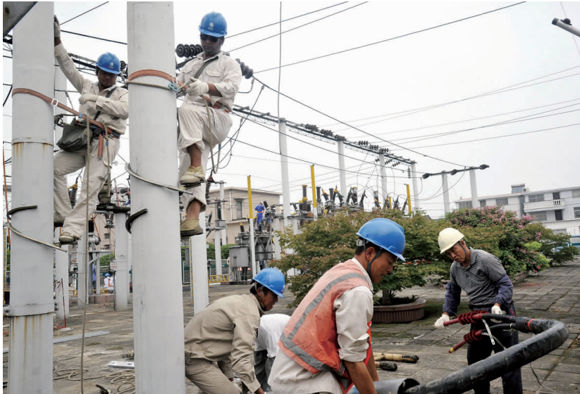
11 日,市供电公司、高邮县城检修分公司组织 80 余名施工人员进行 110 千伏高邮变电站,联合实施市政工程和变电改造工程,在搭接、安装电缆分支箱及构架的同时,还对 24 组 35 千伏刀闸进行了更换。图为施工现场。
