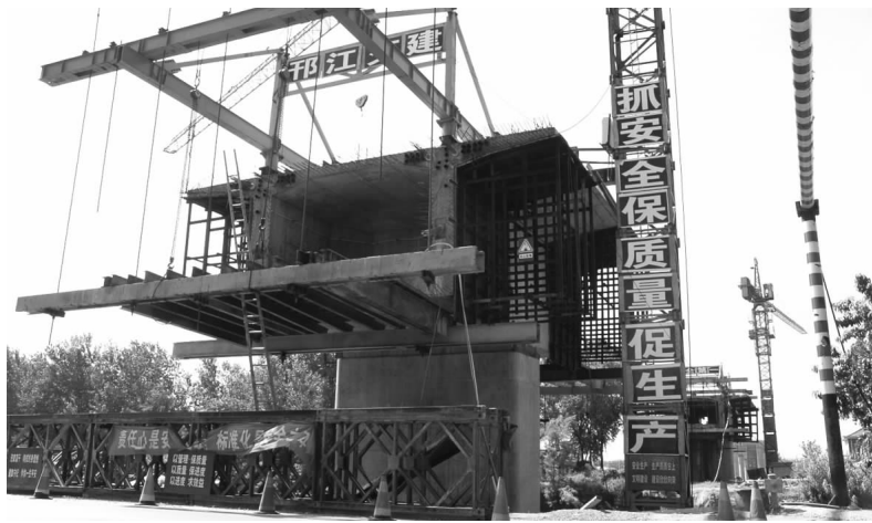
卸甲南圩大桥和汤庄新王大桥是北澄子河上的两个撤渡建桥项目,目前这两座大桥已全面进入引桥上部结构和主跨悬浇施工阶段,预计今年年底建成通行。届时,我市北澄子河航道上的渡口将全部撤除,群众出行更加安全、便捷。图为正在施工中的高邮卸甲南圩大桥。
