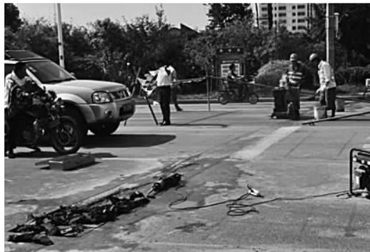
本报讯 23日，本报二版《路面凹坑存在半年无人管》一文见报后，引起了市建设部门的高度重视。该局负责人随即表示，立即调集人员对秦邮路受损路面进行修复。昨日上午，记者再次来到秦邮路和屏准路交叉处的十字路口，看到受损路面所在地段已设好路障，2名维修工人正在用清水对路面进行保养，随后将用沥青冷补料对坑槽进行填充。
