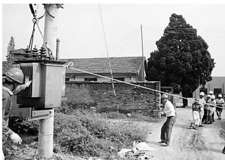
19日，市供电公司借助10千伏龙虬线停电检修之际，对龙虬镇一沟中学1号配变实施移位，以配合龙虬镇招商引资的江苏海潮科技铸造有限公司有关项目的建设。 王卫东 林华鹏 / 摄
