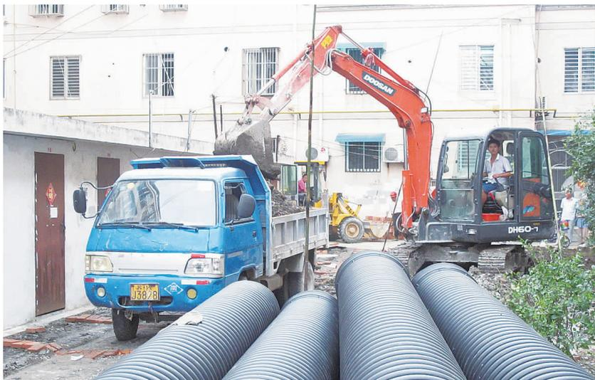
日前，玉带园小区综合整治工程已完成排水管道铺装6500米，夯实路基7600平方米，浇筑混凝土路面2100平方米。连日来，市政工人冒着高温酷暑，全力以赴快速施工，确保在9月上旬保质保量完成任务。图为20日上午记者在施工现场拍摄下的镜头。
