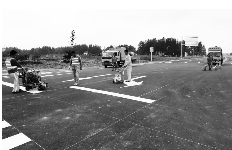
S237省道先导段(高邮泰邮路至马棚段)路面工程已全部完成,目前施工人员正在进一步完善路两边绿化及配套设施,预计10月份有望通车。图为施工人员在马棚段做相关完善工作。王林山 摄
