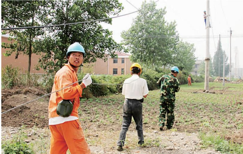
车逻原10千伏车东线由35千伏车逻变供电,由于多年未改造,加之线路长、线径小、设备老化,难以满足车逻南片工农业生产需求。日前,市供电部门及时进行更新改造,将10千伏车东线改为10千伏滨湖线和10千伏宾上线,并接入110千伏迎宾变供电,增加对车逻的供电能力。图为施工人员正在现场布线。 郑红梅 摄
