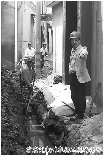
翁宏定(右)在施工现场指挥
