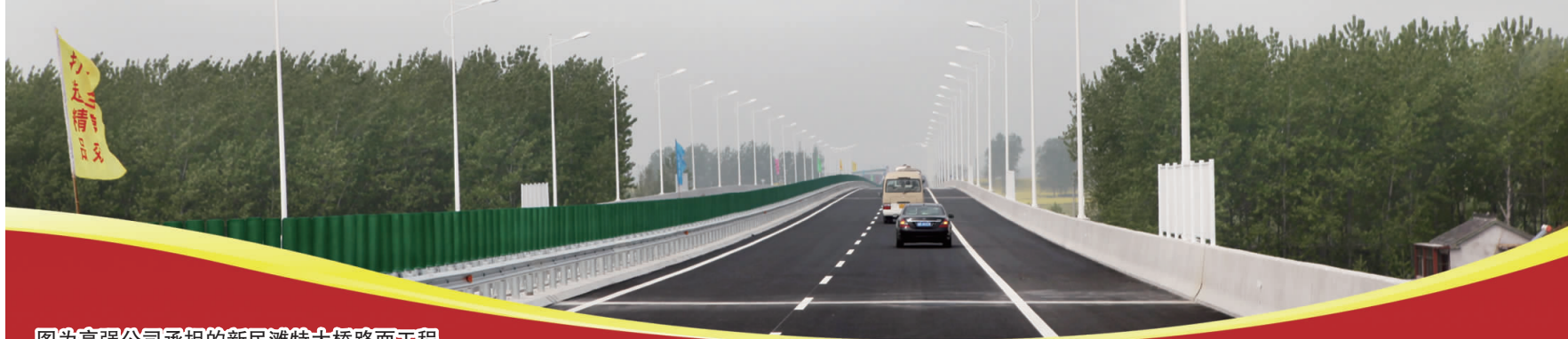
图为高强公司承担的新民滩特大桥路面工程
