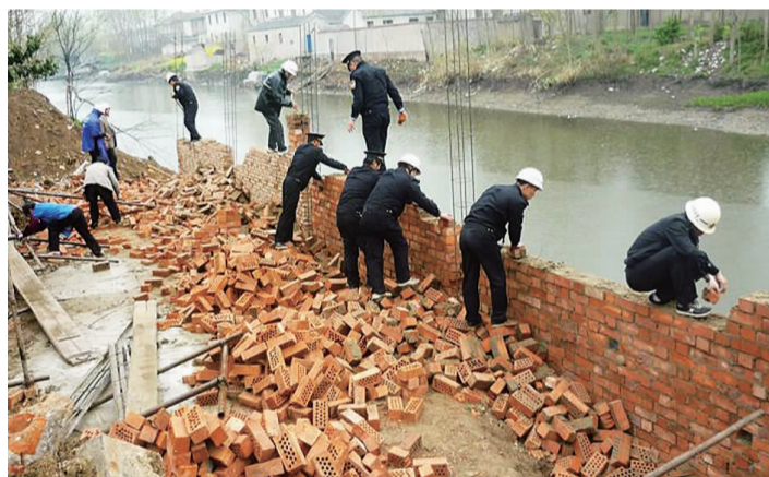
9日,市容管理执法大队与水政监察大队联合执法,在城南新区查处一户在八里河河堤上砌建的违章建筑,并现场进行拆除。 图为拆违现场。 周麟 赵文全 尹宏武/摄
