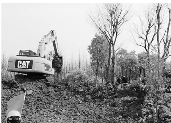
清明节小长假期间,许多单位的工作人员坚守在工作一线,为迎接鸭蛋节的举办做准备。图为3日记者在高速路口段拍下的园林公司工作人员忙碌的场景。
