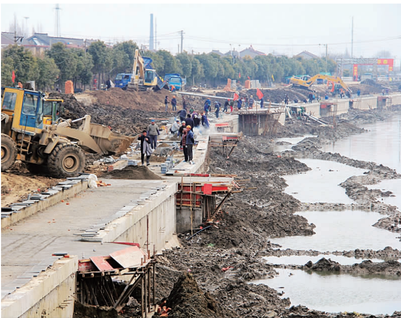
市城投公司投资实施的北澄子河北岸风光带项目,是今年城建双十工程之一,项目西起高邮大桥,东至珠光大桥,全长 2439 米,宽 20 至 65 米,总用地面积约 7.04 公顷。目前,河道清淤、道路拓宽等工程正紧锣密鼓实施。
