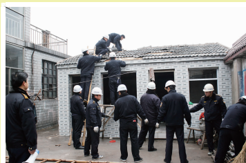
依法拆除违章建设
