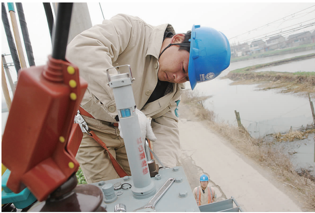
龙虬供电所员工在龙虬镇张轩村唐高墩 15 号变压器安装防撬螺栓。连日来，市供电公司组织 21 个供电所的员工，为今年农网改造中在偏僻地带新增的变压器加装防盗螺丝，以防变压器被盗，影响农民冬季用电。
